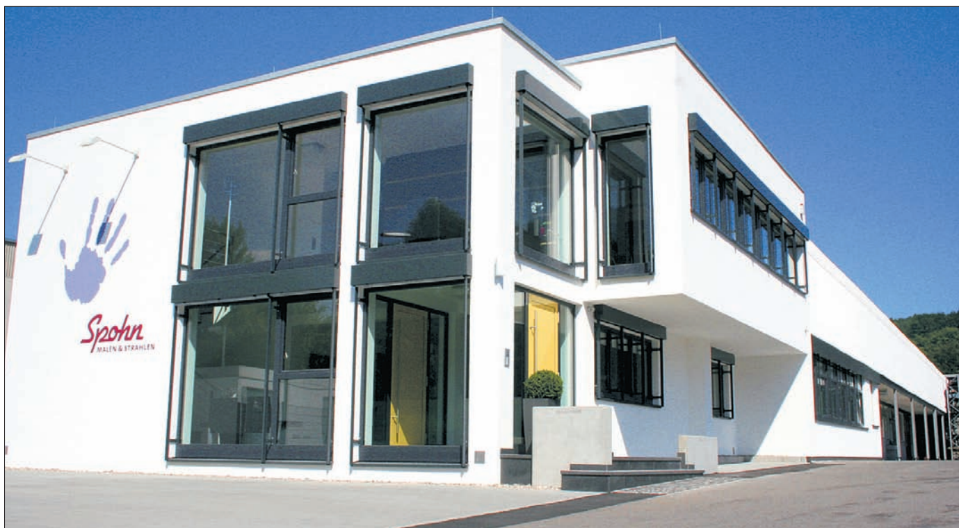
Gelungener Neubau – funktional sanierter Bestandsbau – Stolz des Unternehmens. Foto: zg
