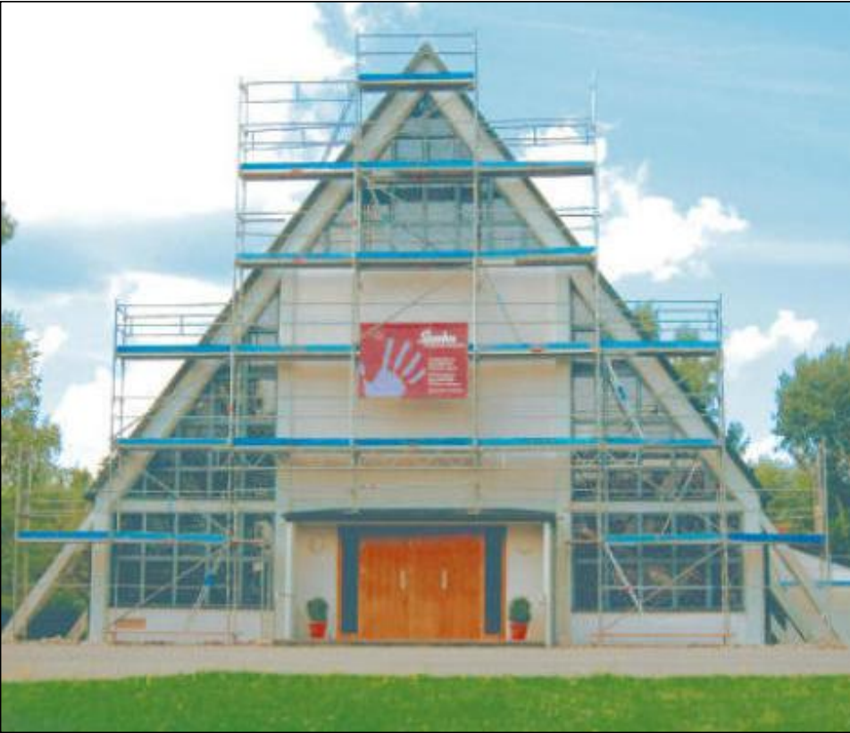
Die Kirche St. Peter und Paul in Scheidentental wird derzeit umfassend saniert. Fotos: J. Casel
